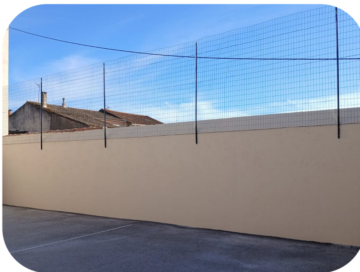
Remise à neuf du mur du terrain sportif de la cour de l'école
