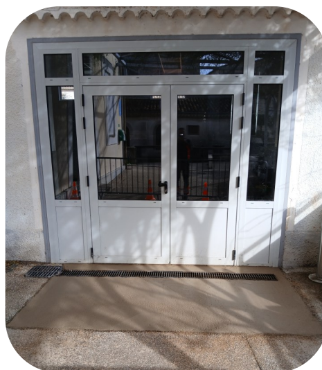
Travaux à la salle des fêtes : canalisation des eaux de pluie
