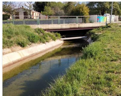
Il a fallu créer de nombreux ouvrages : bâches métalliques, aqueducs, souterrains, syphons, vannes, ponts, etc...Mais aucun réservoir régulateur n'a été aménagé car la roche est calcaire et le sous-sol fissuré. L'irrigation se fait du 15 mars au 15 octobre de chaque année.
